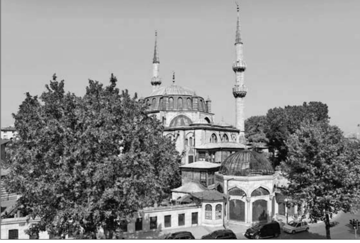
Yeni Vâlide Camii
